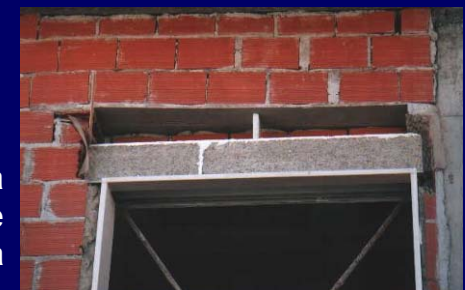
Isolamento térmico da caixa de estore pelo exterior com uma fiada de tijolo furado
