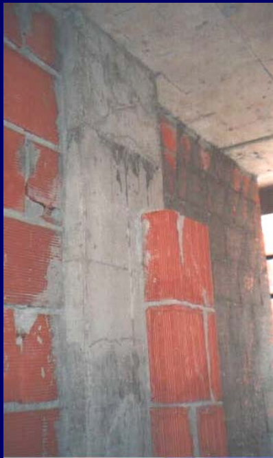
Correcção térmica pelo interior de um pilar em zona corrente com material cerâmico
