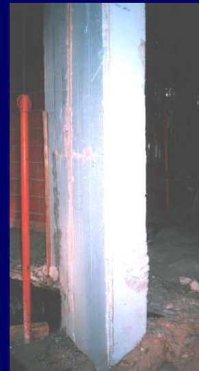
Isolamento térmico de um pilar com poliestireno extrudido
