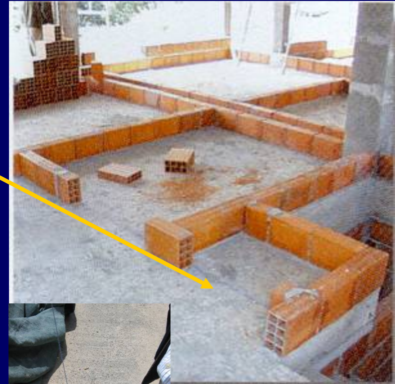
Execução da 1ª fiada
