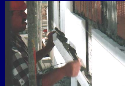
Colocação de uma placa de esferovite na envolvente
