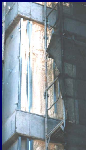
Isolamento exterior com poliuretano
