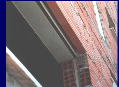
Isolamento térmico da caixa de estore pelo exterior com uma fiada de tijolo furado
