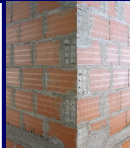
PROCESSO CONSTRUTIVO DE PAREDES DE ALVENARIA
